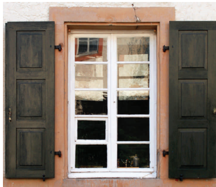
Beispiel eines historischen Fensters, das zum Kastenfenster umgerüstet wurde, Mimbach
