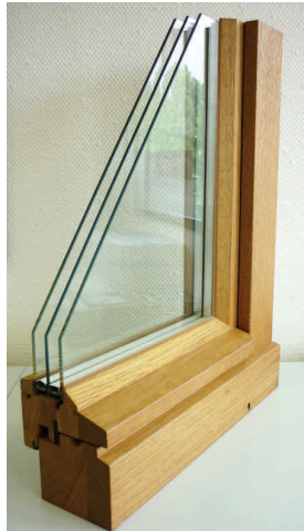
Musterstück eines historischen Fensters der 1950er Jahre mit Dreifachverglasung
