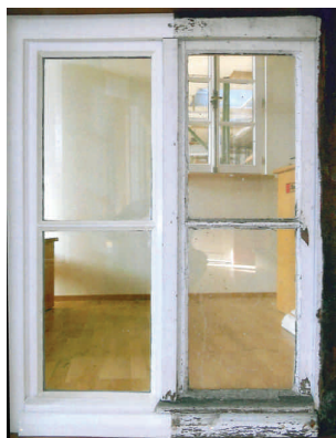
Fensterreparatur mit Glasaustausch
