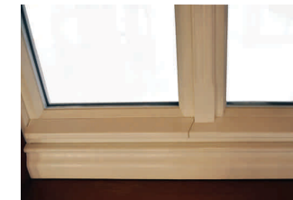
Wetterschenkel mit rechtwinkligen Enden und Überschneidung
