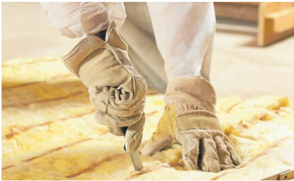
Im Bereich der energetischen Sanierung wird sich einiges ändern
