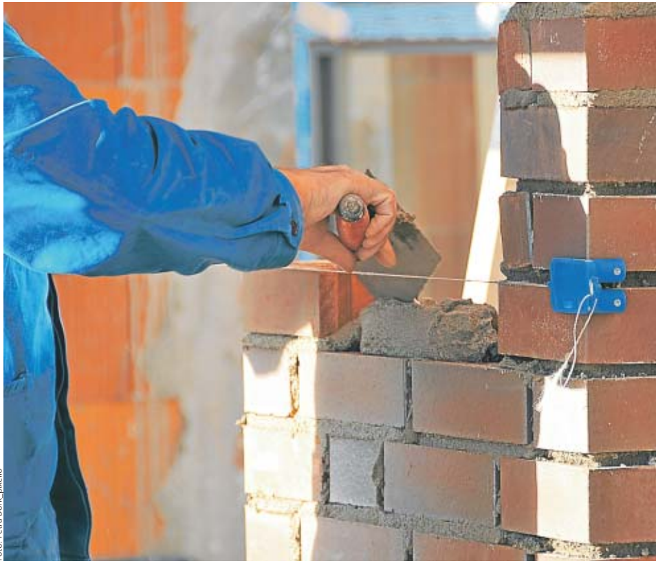
Der Wohnungsbau zog im vergangenen Jahr sowohl bei den Umsätzen als auch den Auftragseingängen an
