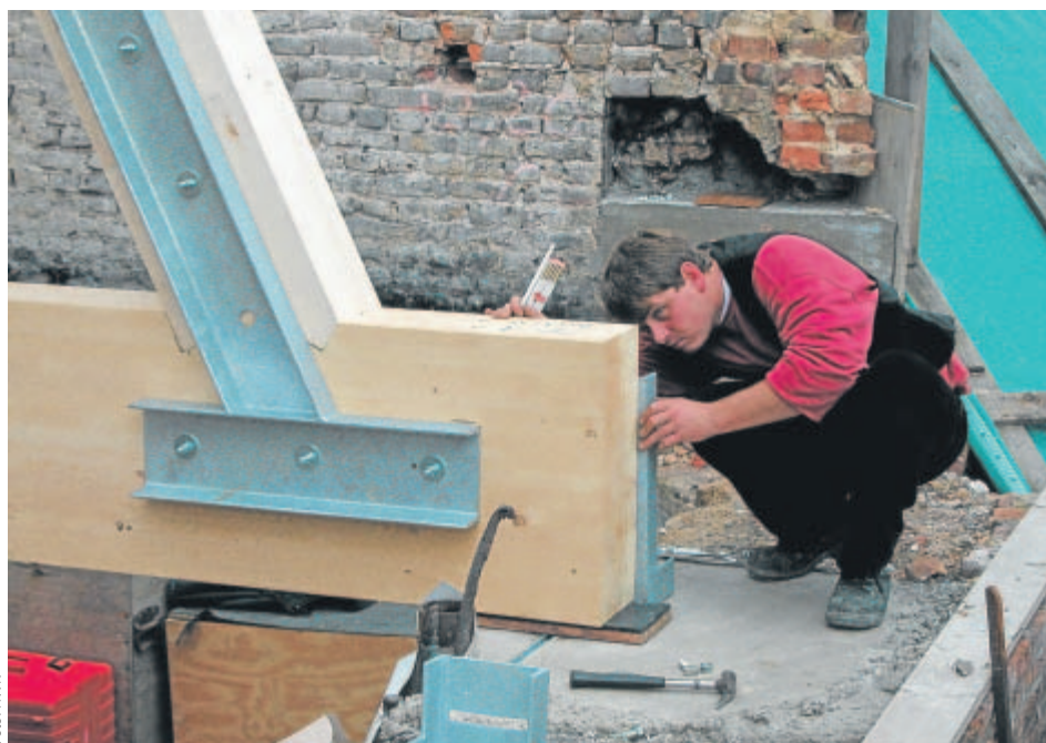
Das Bau- und Ausbauhandwerk hat vom Konjunkturpaket profitiert
