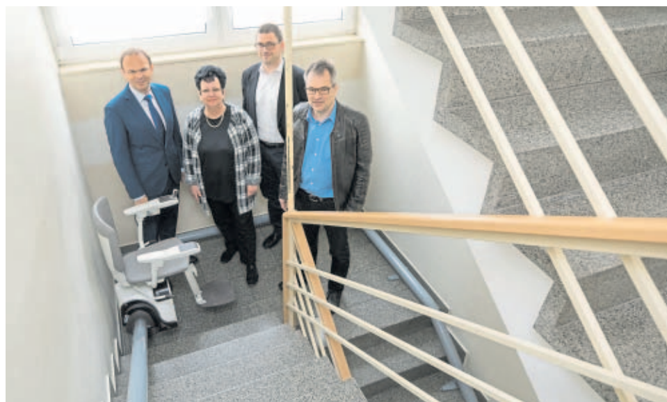
Frau Orth mit den Experten am Treppenlift: Roland Engehausen, Christian Mohr, Matthias Pfau (von links).
