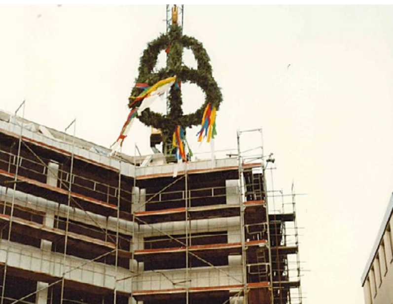
Richtfest für den Verwaltungsneubau im Jahr 1983.
